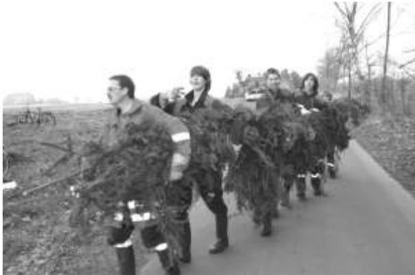
men. Fertig war die Faschine. Die Faschine wurde quer zur Fließrichtung in das Bachbett eingebaut. Damit sie nicht umspült wird, haben wir Einschnitte mit Spaten in das Ufer vorgenommen. Mit vereinten Kräften wurde die Faschine ins Bachbett verbracht, auf Länge geschnitten und an den Ufern eingegraben. Durch das Fichtenbündel wurden dann die angespitzten Pfähle getrieben, um ein Forttreiben zu verhindern. Zudem haben wir im Bachbett Müll gesammelt.
